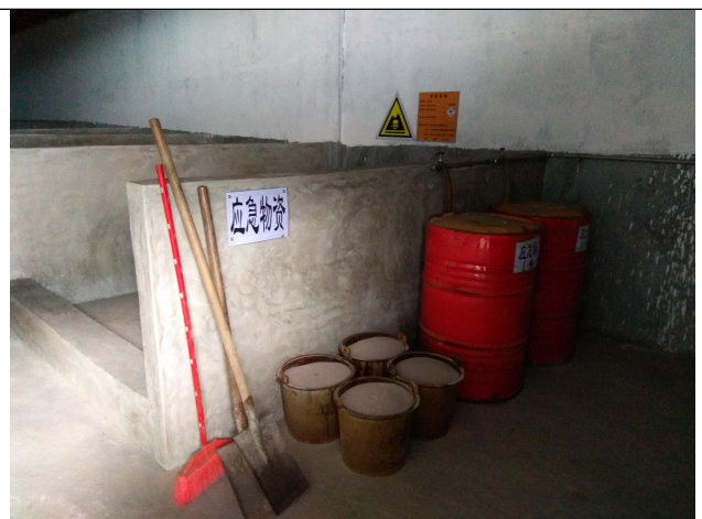
4. 危废储存仓应急物资
