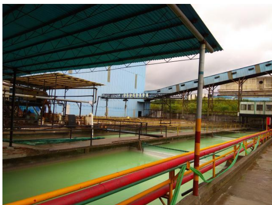
废水处理设施
