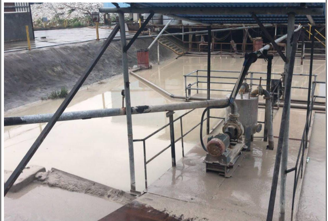
3. 应急池配备水泵
